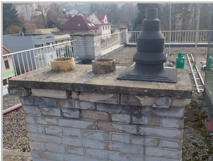
Obrázek č. 17 a 18: Komín od krbu 1.NP / komínové těleso s odkouřením plynové kotelny
